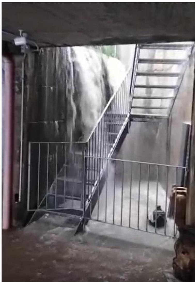
**FIGURA 7 – AUTORIMESSE ALLAGATE PER ROTTURA DELLA TUBAZIONE**
