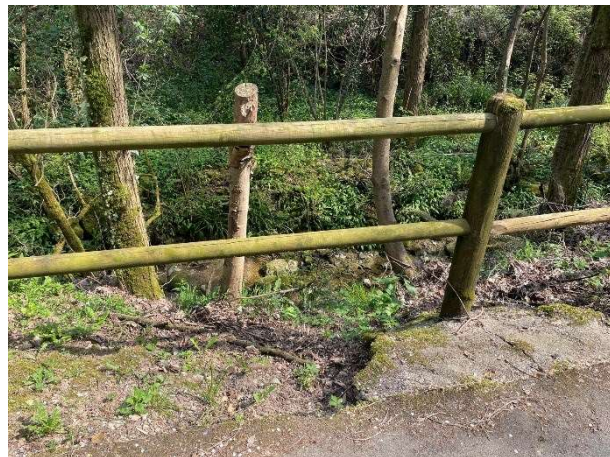
Foto 7-8 Barriera ammalorata su Via Fontanile - oggetto di sostituzione
